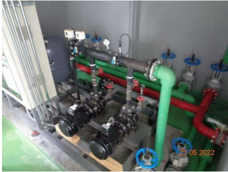
ภาพที่ 2.2-10 ระบบสูบน้ำภายในอาคาร
