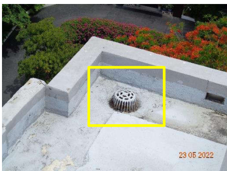
ภาพที่ 2.2-51 การใช้ตะแกรงครอบ รูท่อระบายน้ำ
