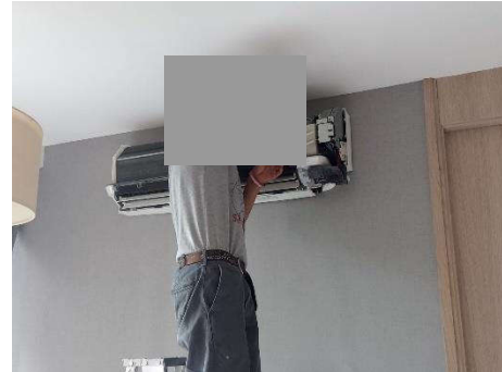
ภาพที่ 2.2-38 การทำความสะอาด เครื่องปรับอากาศ
