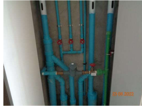
ภาพที่ 2.2-10 ระบบสูบน้ำภายในอาคาร
